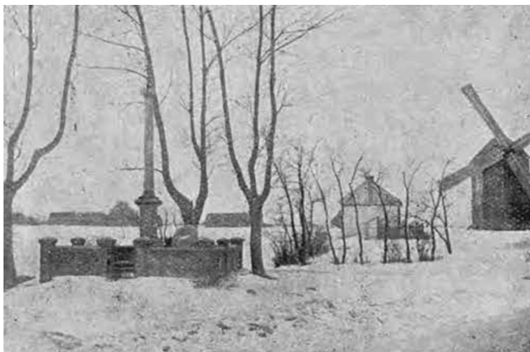
1. Chojny, kolumna, stan z lat 20. XX w., fot. domena publiczna
