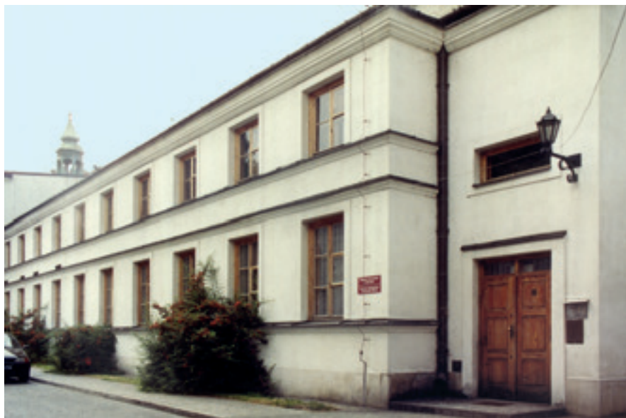
5. Budynek Oddziału Konserwacji Zbiorów, lata 20. XX w.
