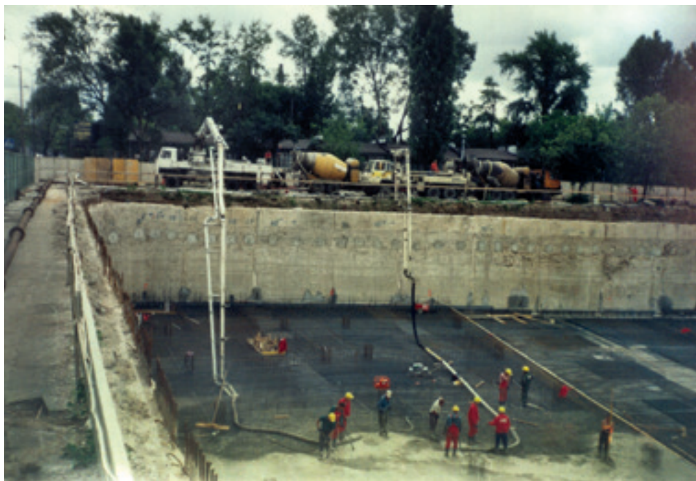
14. Wylewanie fundamentów, 12 VII 1996 r.
