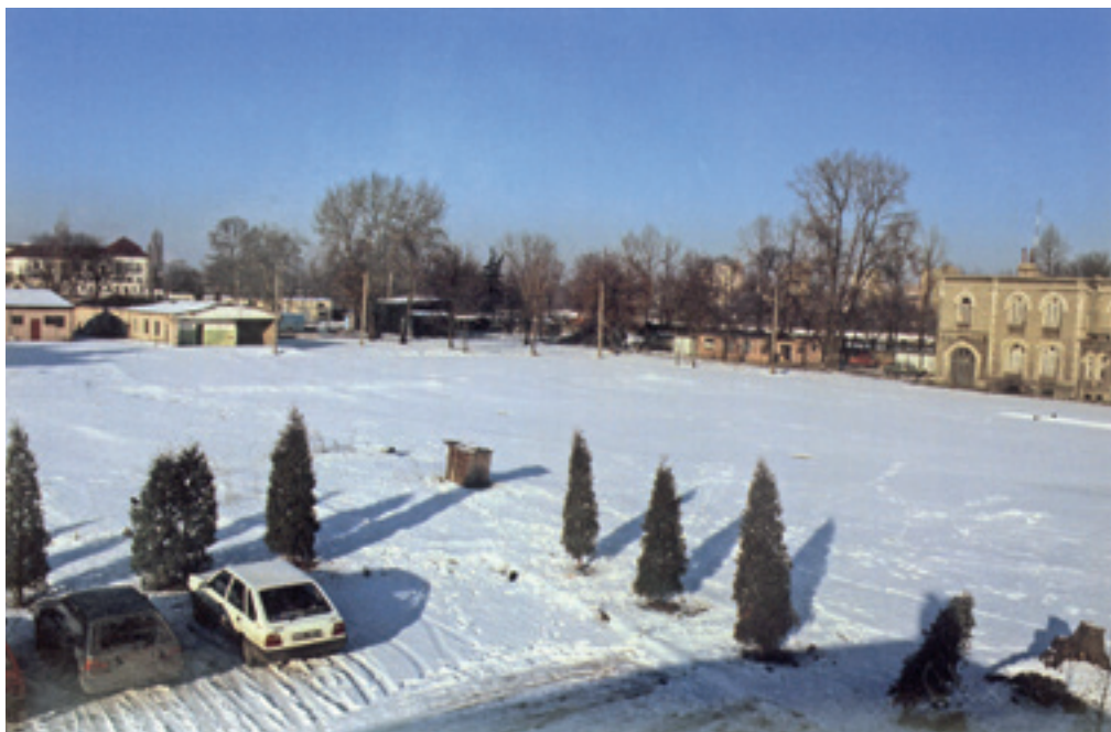
11. Plac na Powiślu przed budową nowego gmachu BUW, zima 1994/1995 r.
