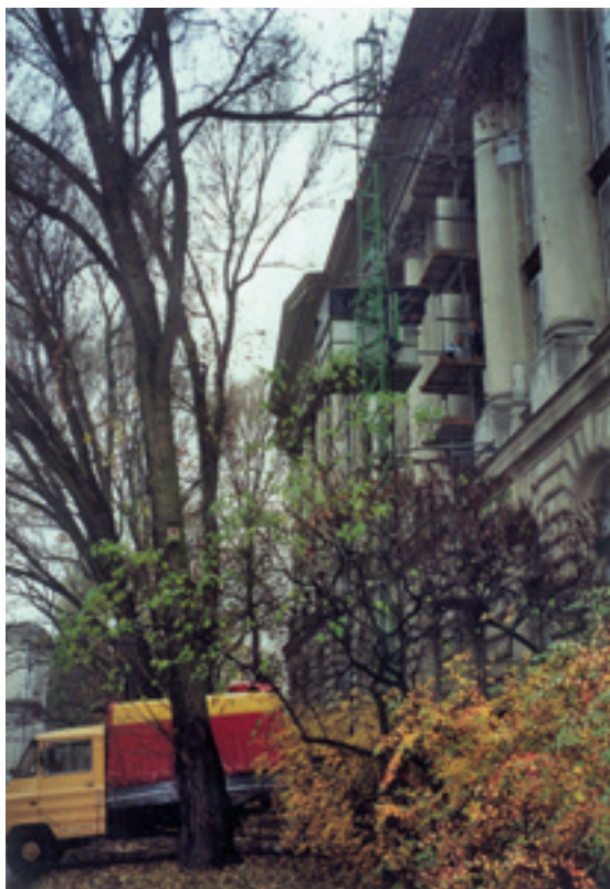
20. Dźwig do transportu spakowanych książek przy południowej elewacji starego gmachu BUW, 1999 r.
