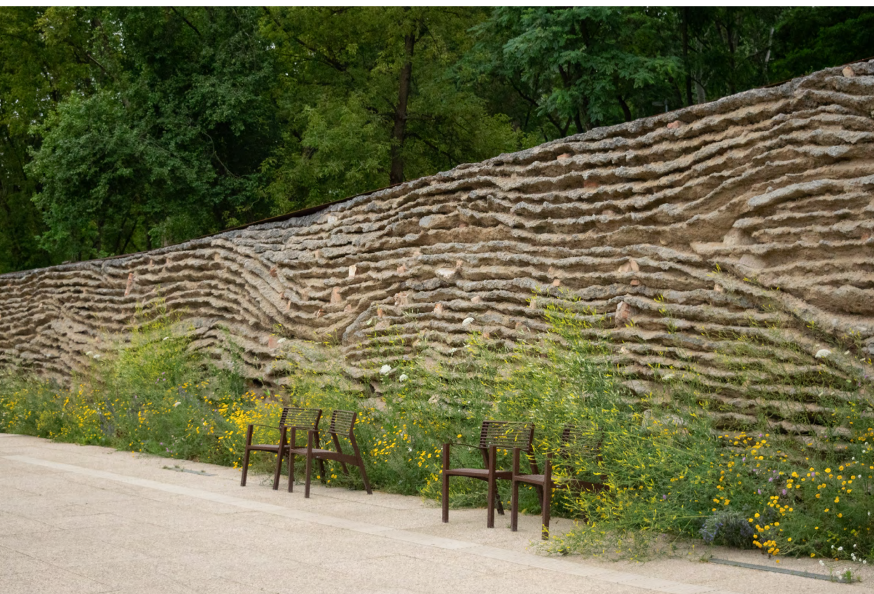
Fotografia 58. Ściana oporowa strefy cokołowej Kopca wykonana z warszawskiego urbanitu (uskoki w poszczególnych półkach pokrywają się z zakończeniem dnia pracy budowniczych)
