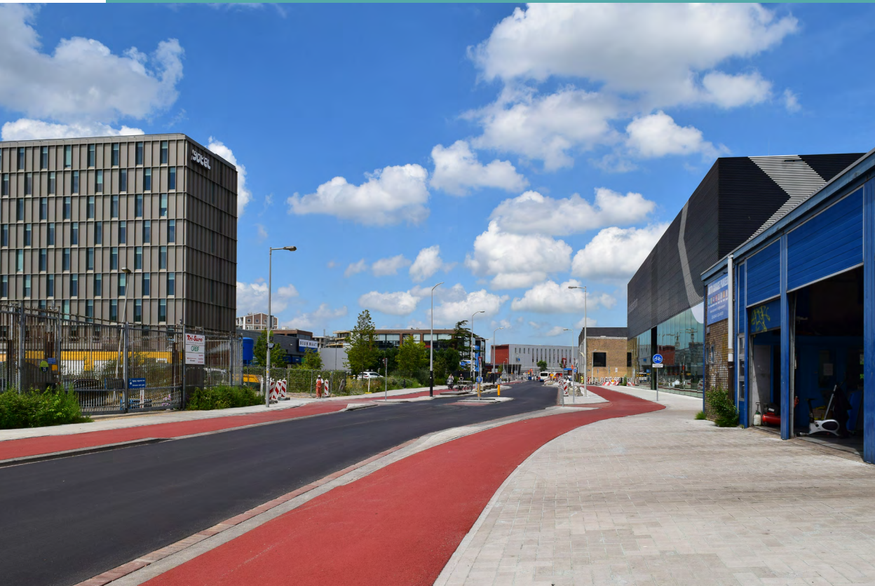
Fotografia 46. Ukończony remont na Asterweg
