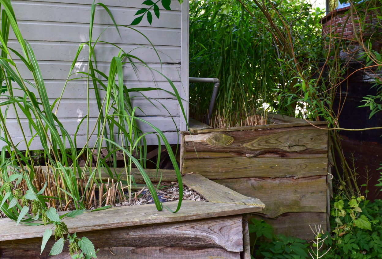
Fotografia 30. Filtry gruntowo-roślinne w De Ceuvel
