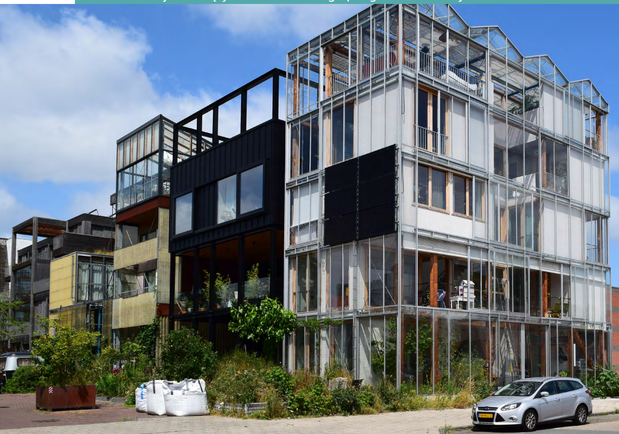
Fotografia 25. Budynek mieszkalny z próżniowymi kolektorami słonecznymi służącymi do całorocznego podgrzewania wody
