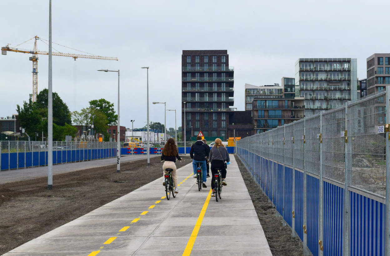
Fotografia 11. Ścieżka rowerowa w dwóch kierunkach oraz ścieżka dla pieszych wytyczone tymczasowo w trakcie prac budowlanych przy Papaverweg
