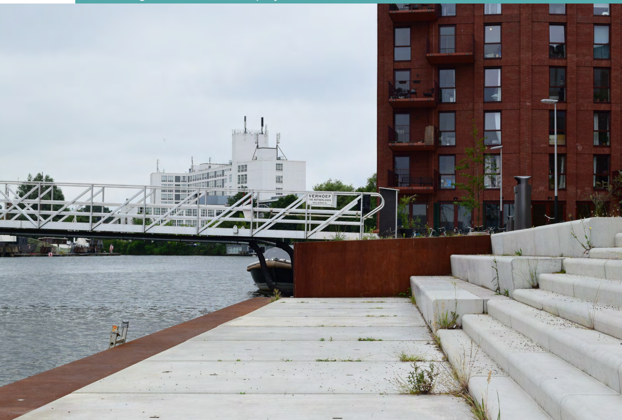
Fotografia 80. Nabrzeże przy Mariadistelkade
