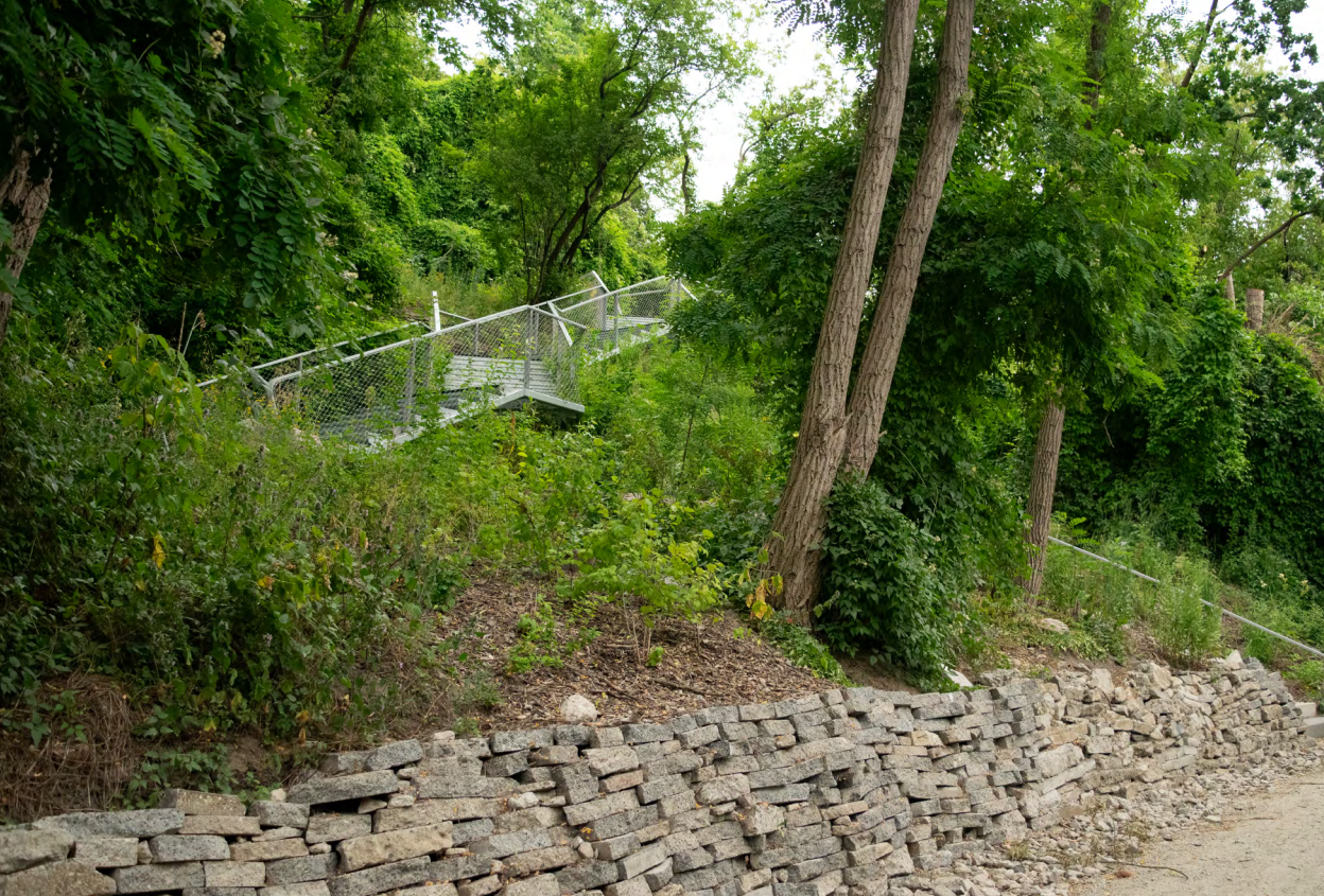
Fotografia 59. Murek oporowy układany bez zaprawy, wykonany z płyt z Kanału Piaseczyńskiego
