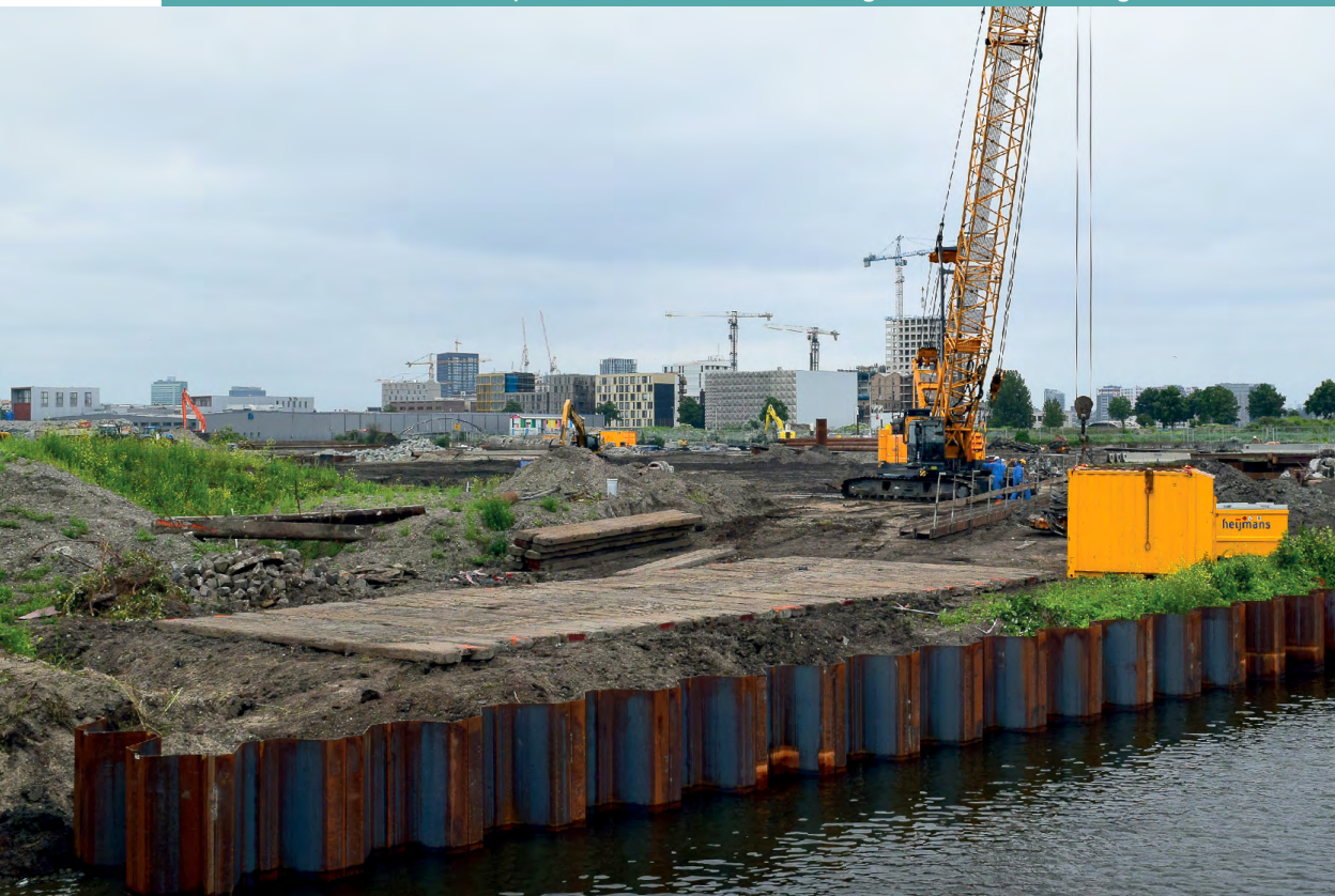
4. Prace budowlane na południe od mostu zwodzonego Theo Fransmanbrug
