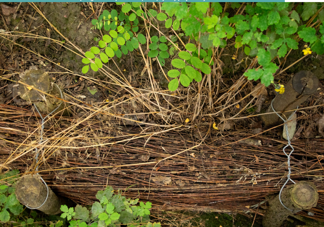
Fotografia 63. Kiszka faszynowa, która umacnia skarpę oraz zatrzymuje materię organiczną oraz impet spływającej wody
