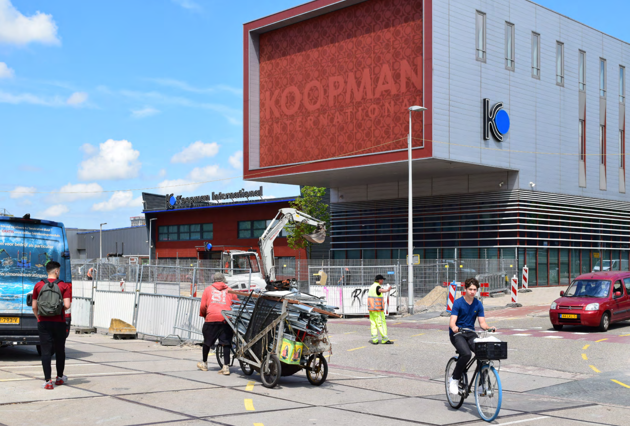
Fotografia 45. Skrzyżowanie Distelweg i Asterweg podczas przebudowy
