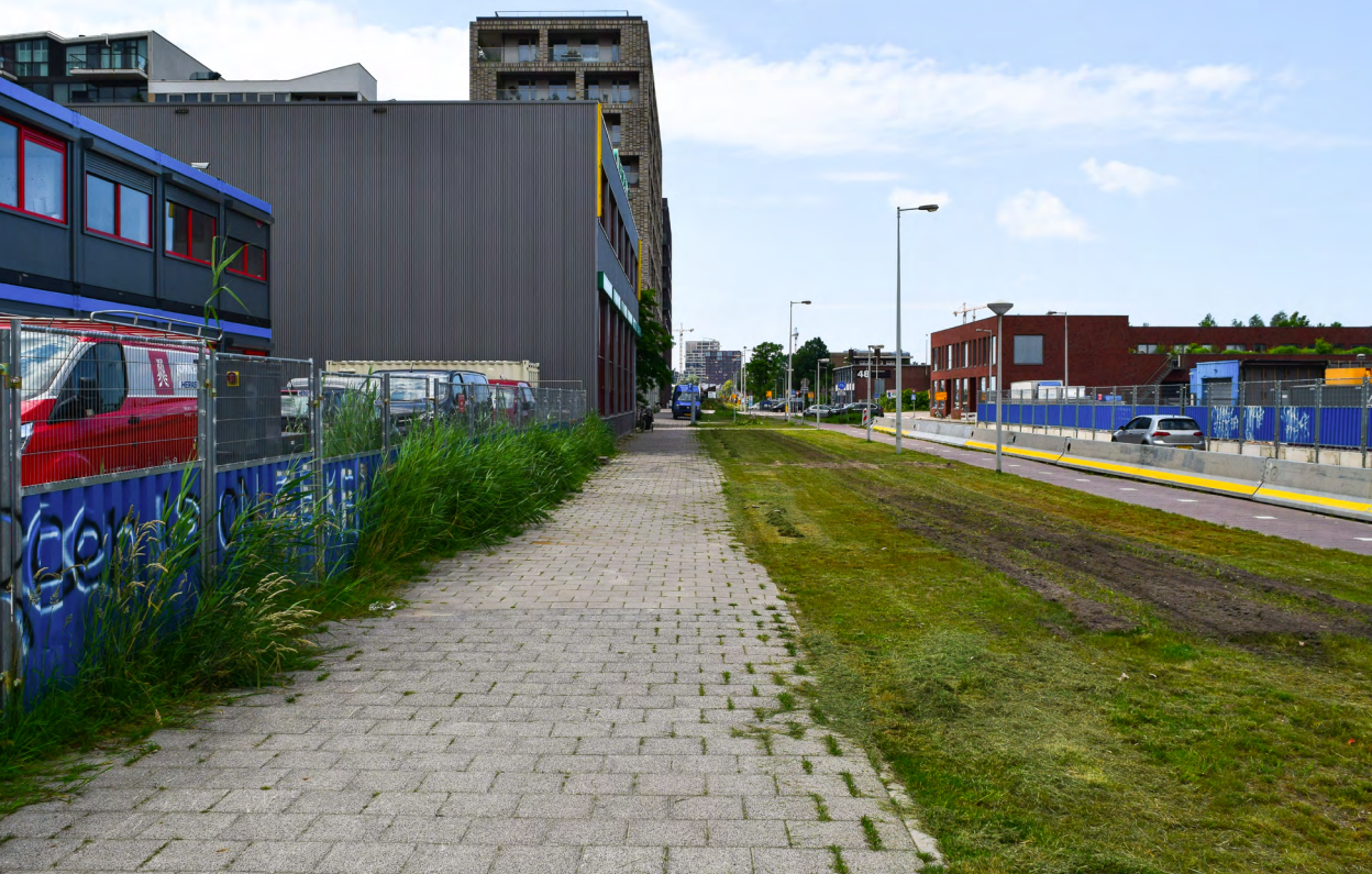
Fotografia 51. Łąka zasiana przy skrzyżowaniu Papaverweg i Fonteinkruidstraat (2021)
