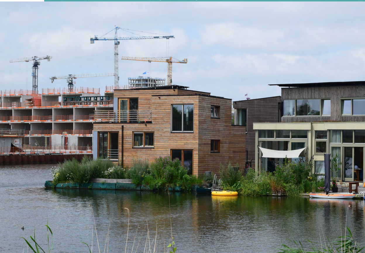
Fotografia 12. Osiedle domów jednorodzinnych na wodzie Schoonschip (w tle prace budowlane przy Distelweg)
