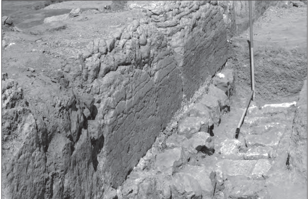
Fig. 53. La fondation du mur sud passant sous celle des pièces A 2 et A 3 de la maison du préfet
