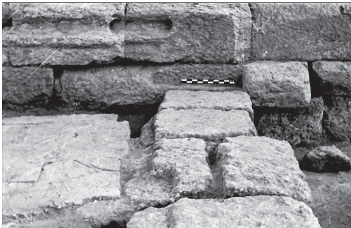
Fig. 121. Le bloc en porte-à-faux dans l'angle sud-est du naos, indiquant le niveau de la banquette d'origine
