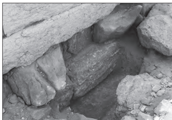
Fig. 14. La fondation du mur sud du temple sous le degré entaillé du hamana
