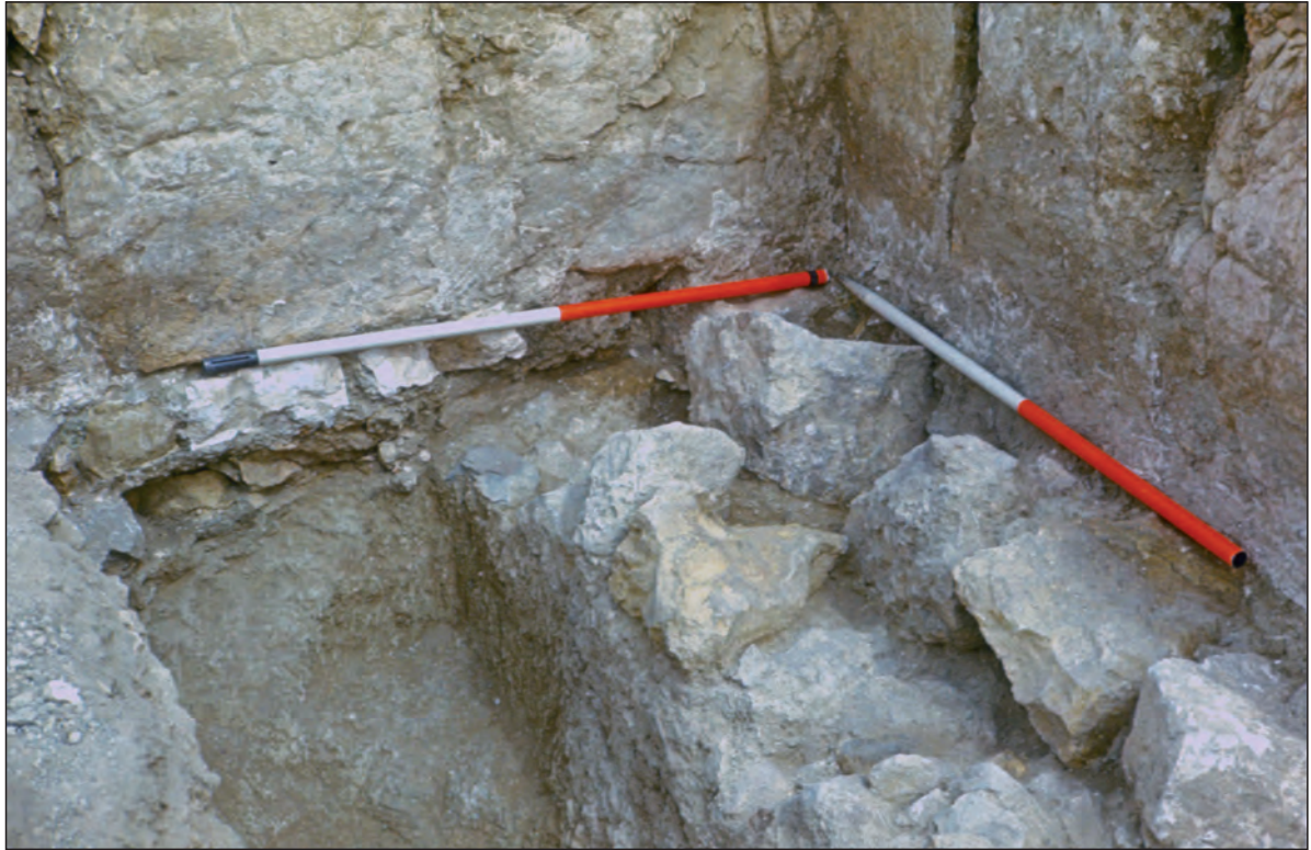
Fig. 52. La fondation du mur sud sous la pièce A 4 de la maison du préfet (ALLAT V)
