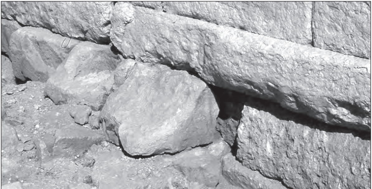
Fig. 18. La fondation du mur nord du temple avec les blocs du degré incorporés et tardivement entaillés du côté intérieur
