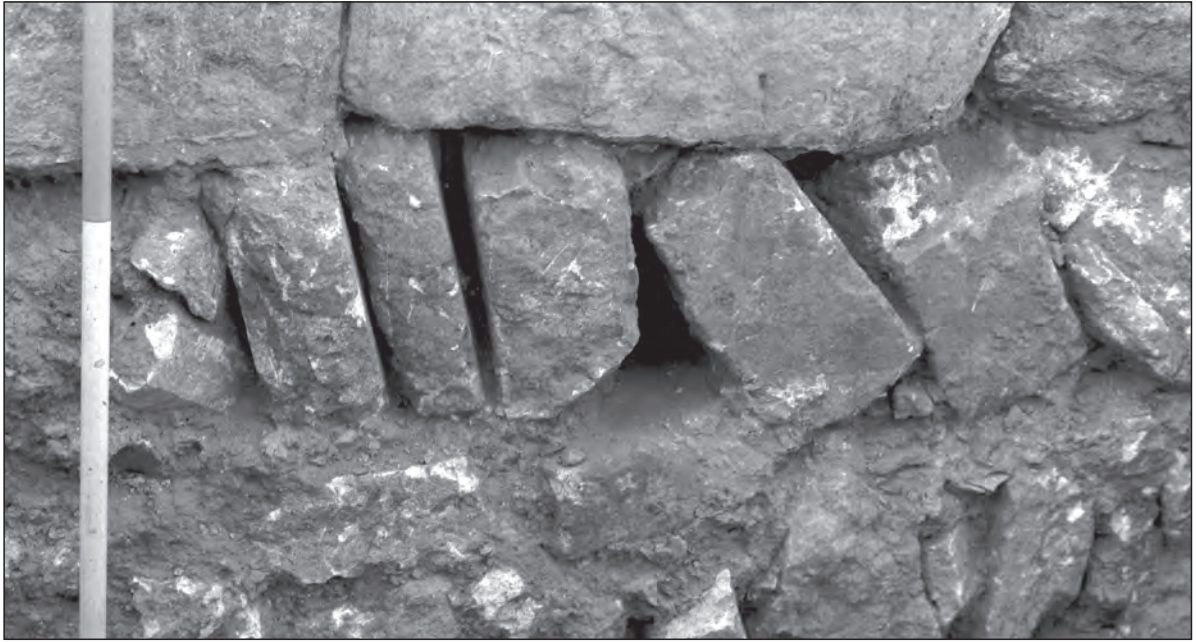
Fig. 56. Les fondations du mur est tétrarchique, côté intérieur
