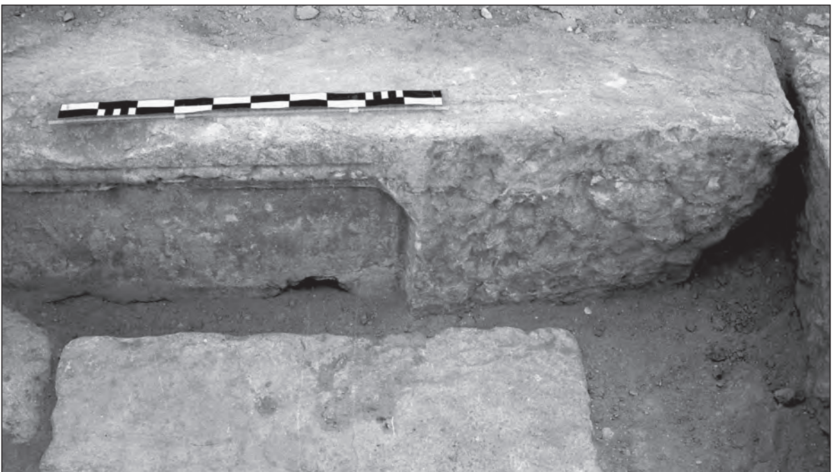
Fig. 110. L'angle sud-ouest du pronaos avec la moulure du socle des colonnes du côté sud. La moulure du côté ouest n'est pas conservée
