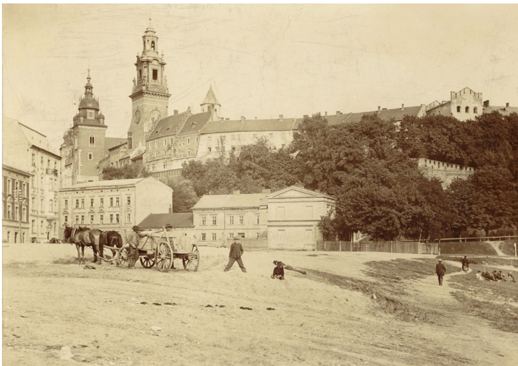
Zakole Wisły pod Wawelem, woźnica oczekujący na brzegu, po 1906 roku. Autor fot. nieznaný ŹRÓDŁO: ZE ZBIORÓW MUZEUM HISTORII KRAKOWA, NR INW. MHK-FS17909/IX
