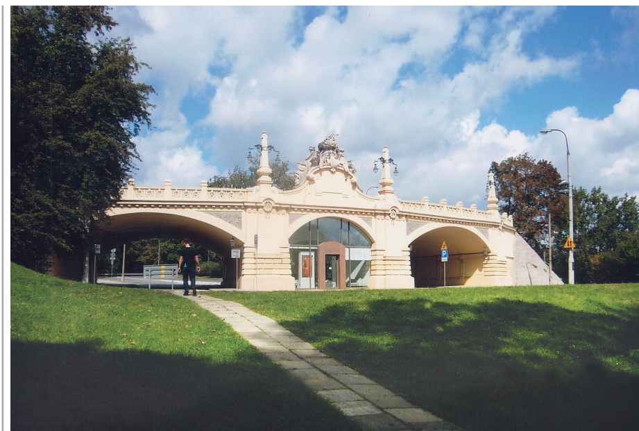
Wiadukt Markiewicza od strony ulicy Gęstej (zdjęcie współczesne)
