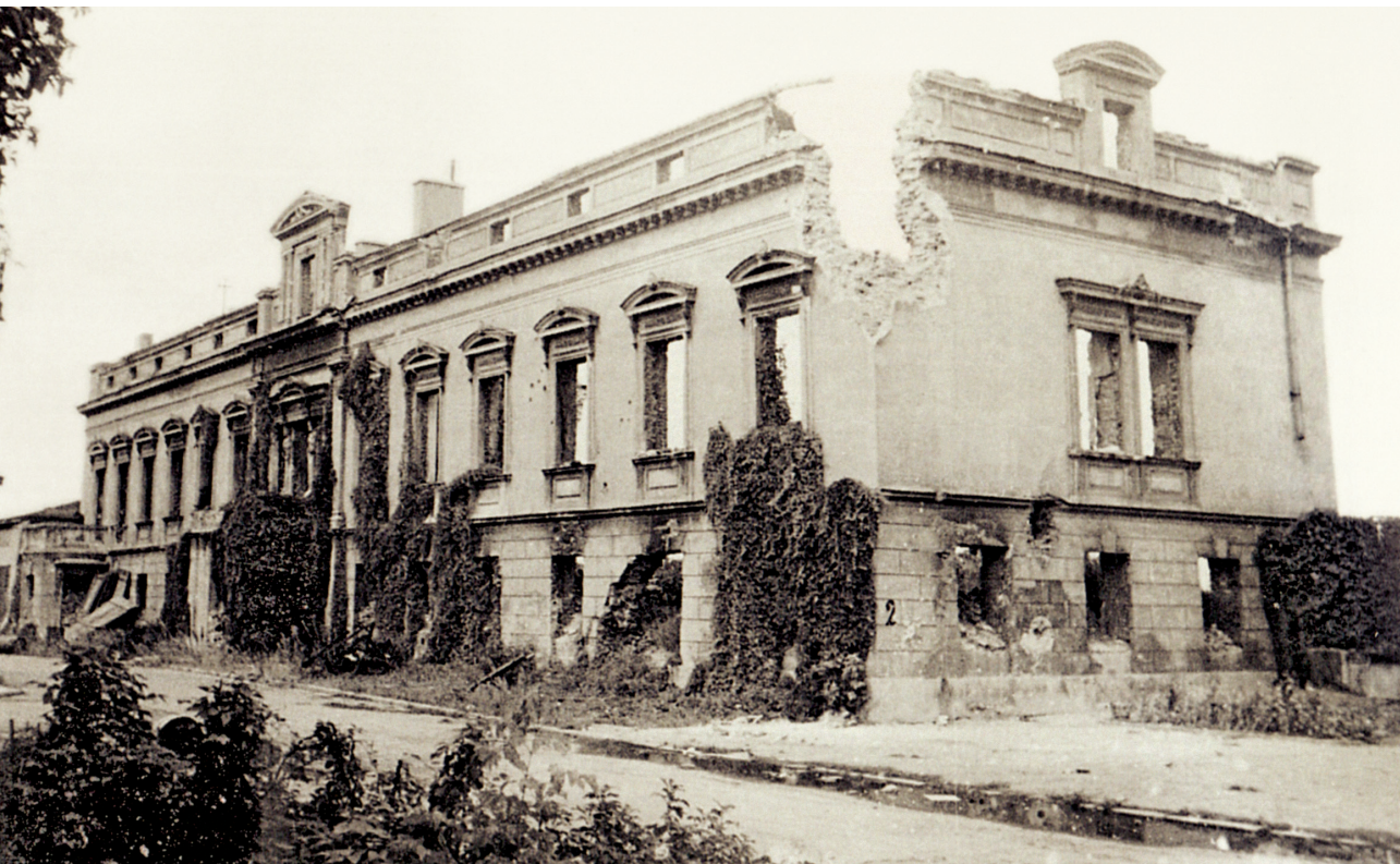
Budynek Pokuratorski (zniszczenia z 1939 r.)
